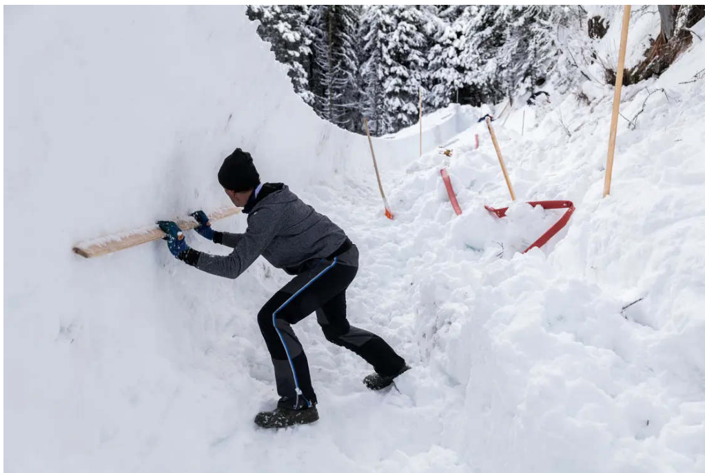
Mit einer Holzlatte werden die Schneewände verputzt – ein paar der Südtiroler sind im Hauptberuf Maurer.
